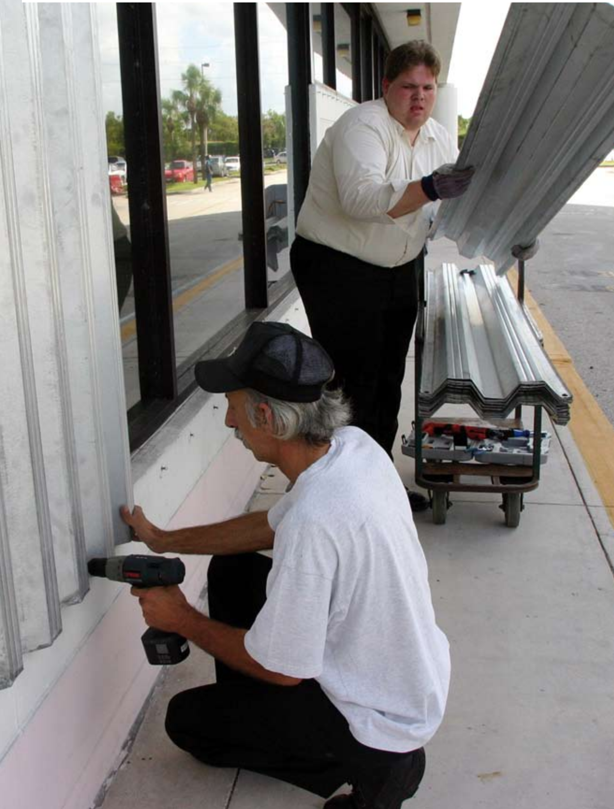
Empleados de una tienda instalan protecciones contra el huracán Jeanne en Florida, EE.UU. Foto Reuters/Marc Serota
